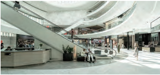
防火门监控系统-购物中心
