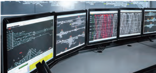
智慧消防物联网系统-监控中心
